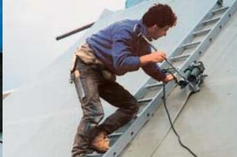
Аппарат X84 при сварке пароизоляции на наклонной кровле. Легкий, весом 6,1 кг, аппарат преодолевает любой наклон с постоянной скоростью.
