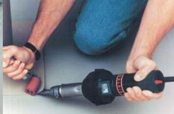
Аппарат ТРИАК PID с щелевой насадкой 20 мм и прикаточный ролик при сварке кровельного покрытия.
