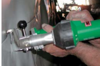
ТРИАК ДРАЙВ PID при сварке горизонтального шва при строительстве тоннеля.
