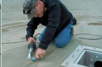
ТРИАК PID с щелевой насадкой при сварке стыков.
