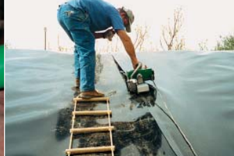
При использовании автомата АСТРО получают сварные швы наивысшего качества при работе на самой высокой скорости - 5 м/мин.
