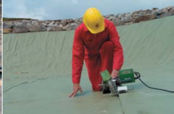
ТВИННИ Т при сварке искусственного водоема.
