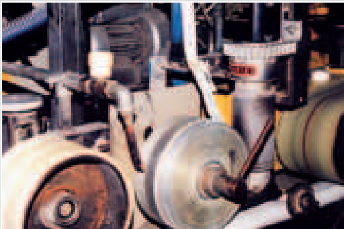
Воздуонагреватели с вентилятором при заварке бесконечного шланга из ПВХ.
